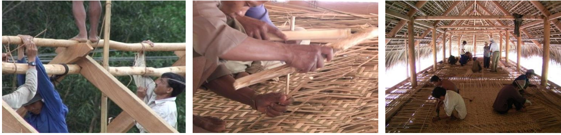
様々な在来建築技術（釘を使わない部材接合技術、巧みな竹編み技術）
