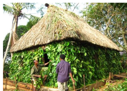
フィジー伝統木造住居ブレ再建
